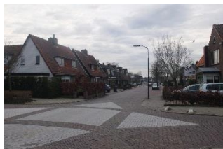
Koenestraat zuidelijk deel
