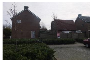
bijgebouw Pr. Irenelaan
