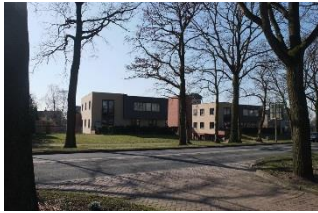
nieuwbouw bij Maallust
